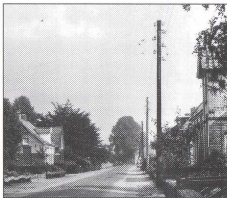
fig. 1. Electriciteitspalen waren vroeger een vertrouwd gezicht. Men kon ze, zoals bijvoorbeeld hier op 't Hoge in de jaren '60, langs de meeste wegen aantreffen (ansichtkaart).
